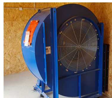
Ventilateur Insuffle l'air sous les caillebotis
