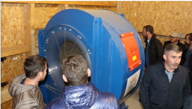
Le ventilateur de 50 000 m 3 /h aspire l'air chaud sous la toiture et la pousse sous le tas de fourrage.
