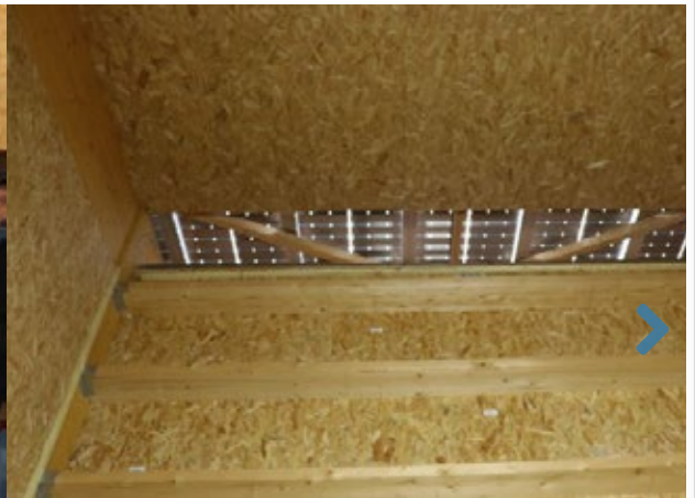
Le couloir sous le toit du bâtiment permet à l'air de d'être réchauffé via l'échangeur thermique du p
