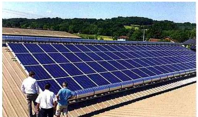
démonstrateur du Barp (Gironde) de 600 m<sup>2</sup>, muni de 360 panneaux en toiture, qui traite jusqu'à 5 000 tonnes de bois par an et fournit un combustible plus sec, adapté aux chaudières biomasse tout en limitant les émissions polluantes.
