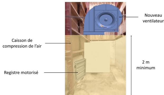
Proposition d'un caisson de compression avec ventilateur
