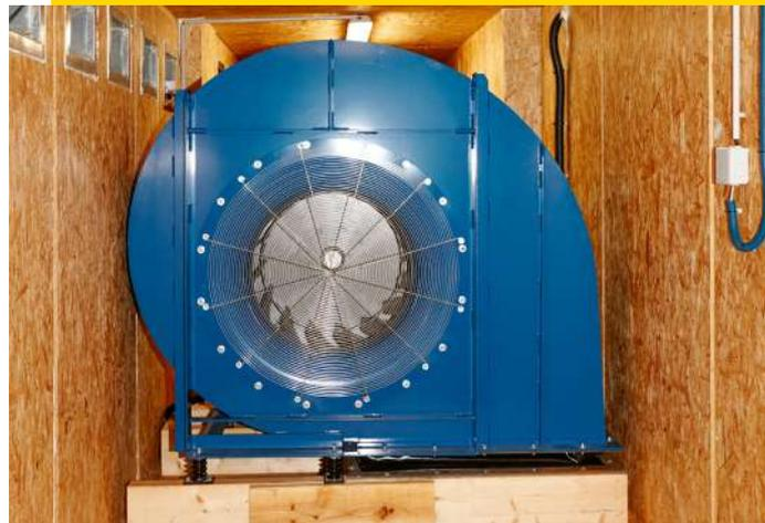
Tous nos ventilateurs sont installés sur des silencieux afin d'absorber les vibrations lors du fonctionnement garantissant ainsi une plus longue durée de vie.
