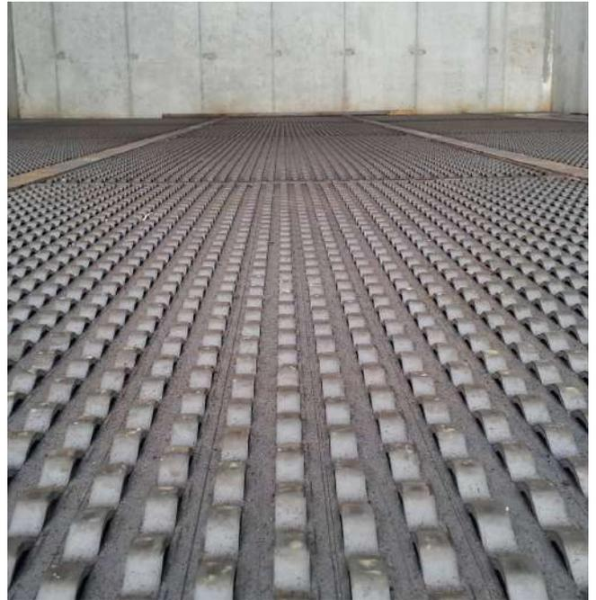
Ces tôles extrêmement robustes permettent la circulation d'engins lourds pour le chargement et le déchargement de la matière à sécher. La case de séchage à plat est l'outil idéal pour un séchage polyvalent multi-matières. Au fil des années, BASE est devenu un spécialiste de la conception mécanique et aéraluque des structures de séchage à plat.
