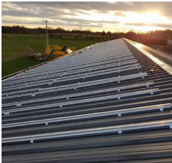
Les panneaux reposent sur un système de rails Iso-Solar-Dry® sur bac acier fixé sur les pannes de la charpente.
