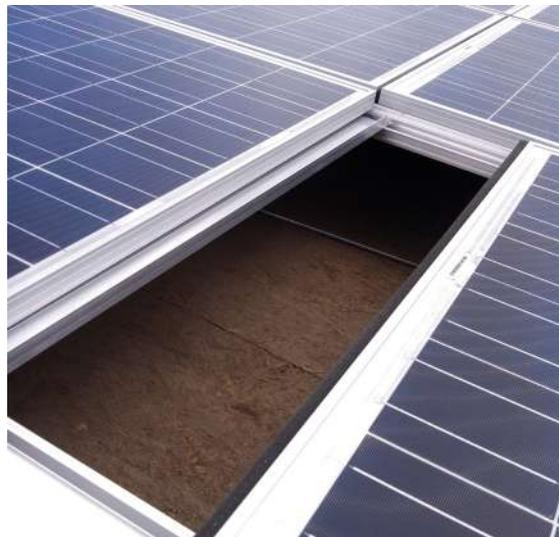
La circulation de l'air se fait entre les panneaux et une double peau sous toiture. Les panneaux assurent la couverture du bâtiment.
