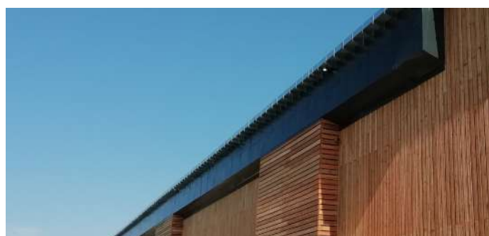
Closoir et gaines Récupération d'air chaud
