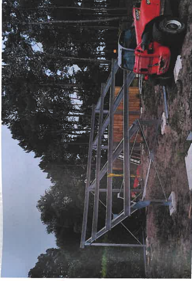
Les panneaux seront posés au sol sur une structure métallique porteuse inclinée à 20°.
